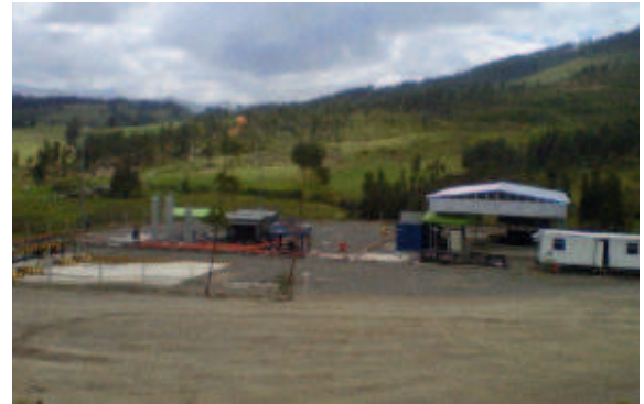
ESTACIÓN DE GAS
